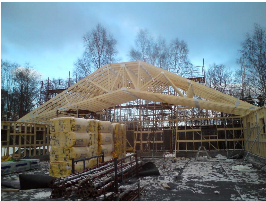
Flere takstoler på plass. Foto: B. E. Baadshaug 2016
