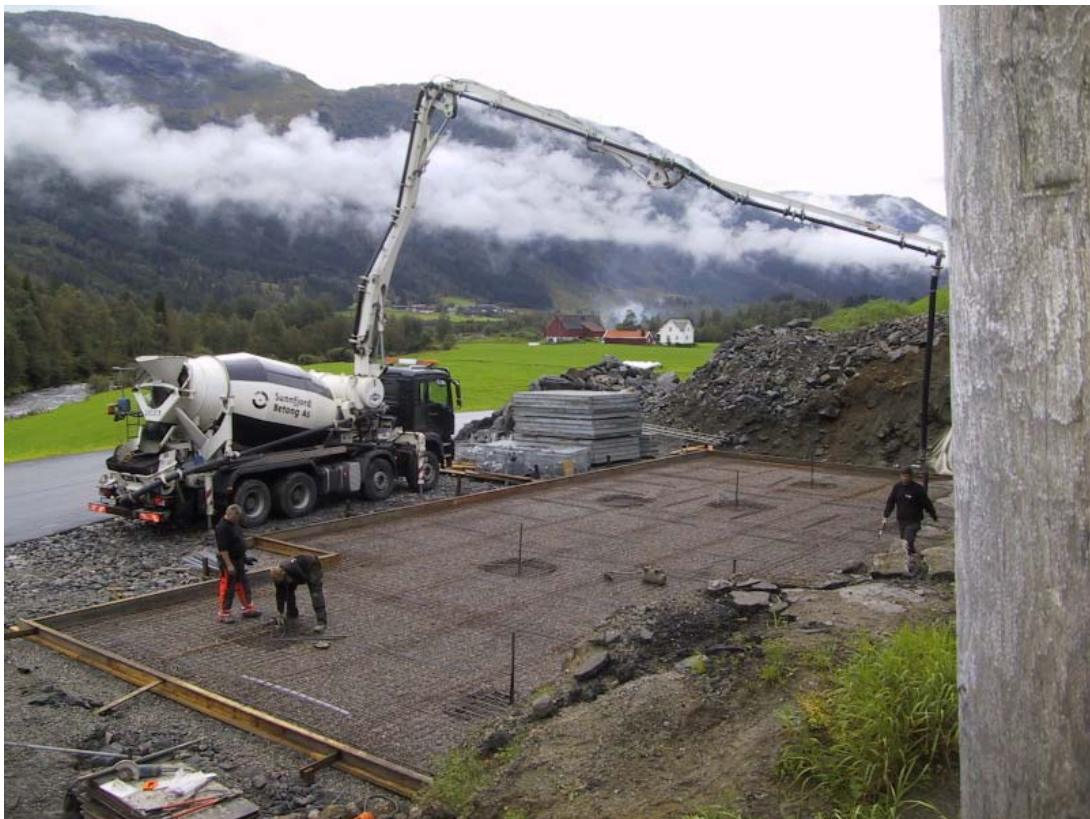
Betongbil klar til å legge fundament. Foto: O. Kvamsås (2016)
